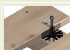
další terasové prkno zalicovat a přiložit
